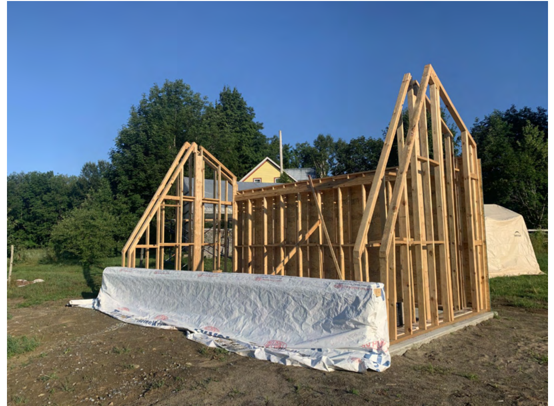
La charpente de double ossature
