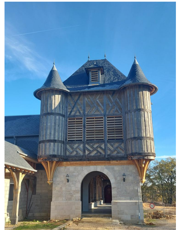
Monastère Orthodoxe de la Transfiguration, Terrasson (24) Application Manuelle Banchée BATICHANVRE® ISOCANNA® et KALAMUA® Ossature bois remplissage en béton de chanvre
