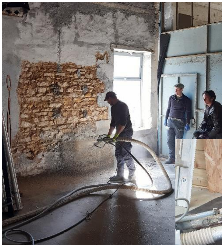
Projection mécanique : Sur mur support
