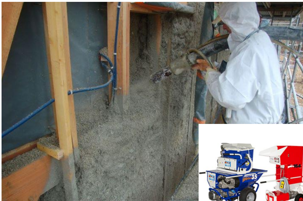
Projection mécanique : Sur structure ossature bois
