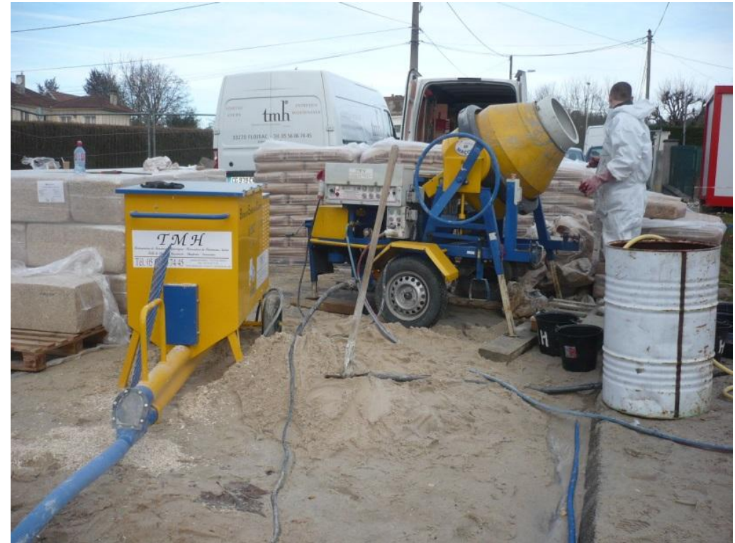
Bibliothèque Périgueux 24 BATICHANVRE® ISOCANNA® enduit Chaux Naturelle Ossature bois projection mécanique du béton de chanvre
