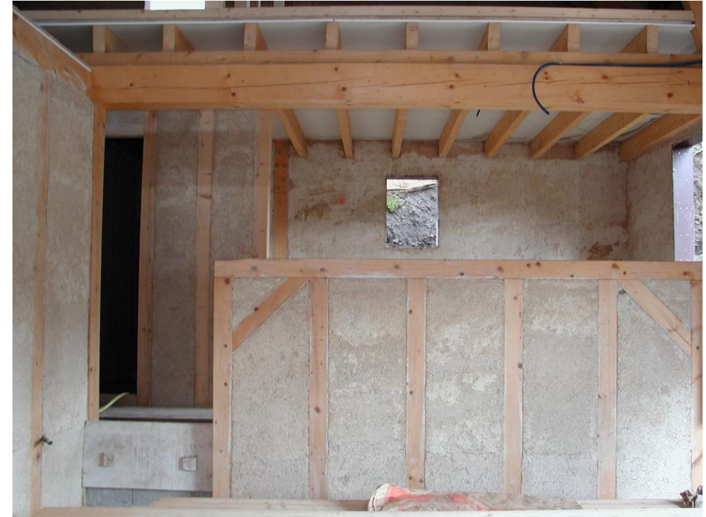
Maison individuelle à Orbois (14) Application Manuelle Banchée BATICHANVRE® ISOCANNA® Ossature bois remplissage en béton de chanvre Murs extérieurs et cloisons intérieures
