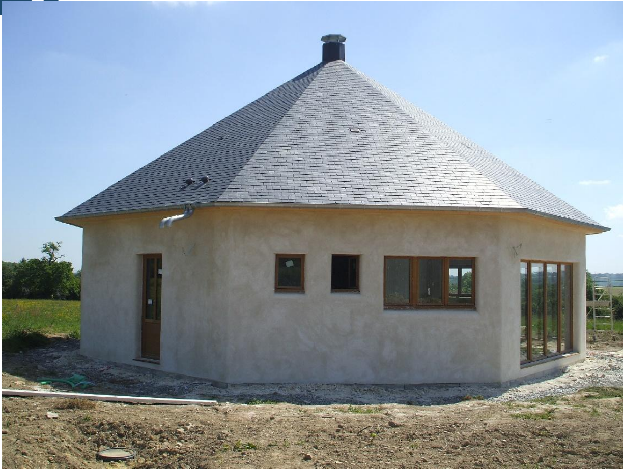
Maison individuelle à Orbois (14) Application Manuelle Banchée BATICHANVRE® ISOCANNA® Ossature bois remplissage en béton de chanvre Murs extérieurs et cloisons intérieures
