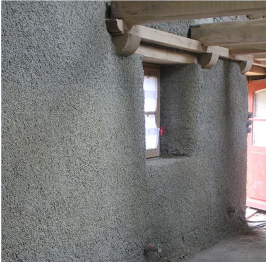
Mur isolé en béton de chanvre projeté
