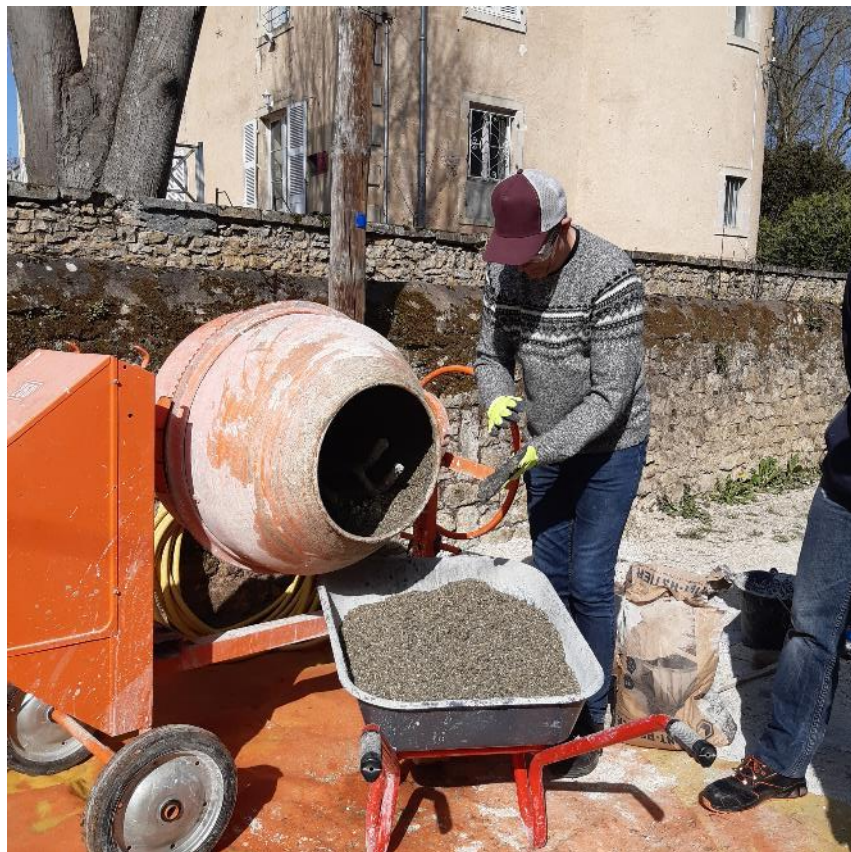
Mélange à la bétonnière (liant + chènevotte + eau)
