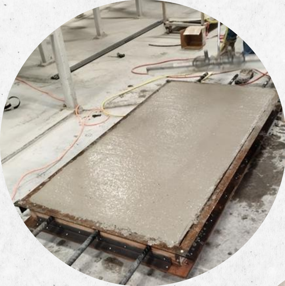
Coulage d'une dalle
